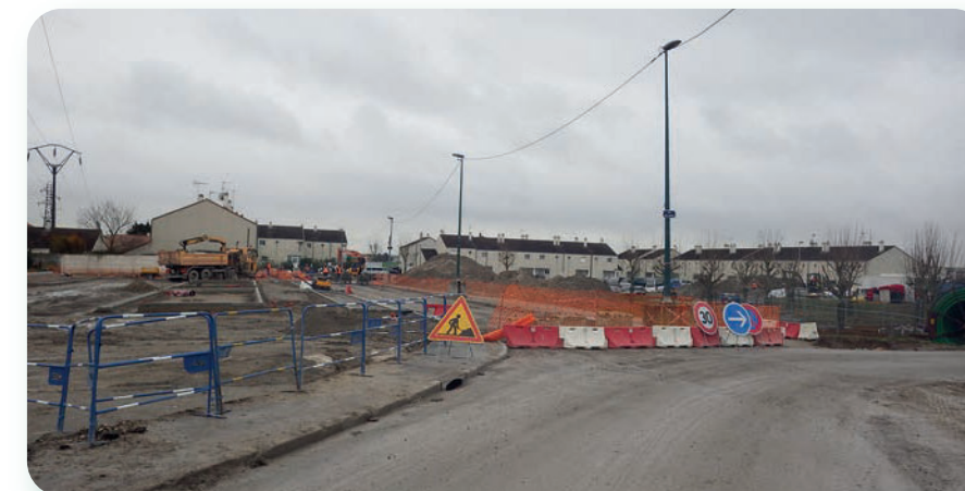
Rue Sainte Thérèse actuellement en travaux
