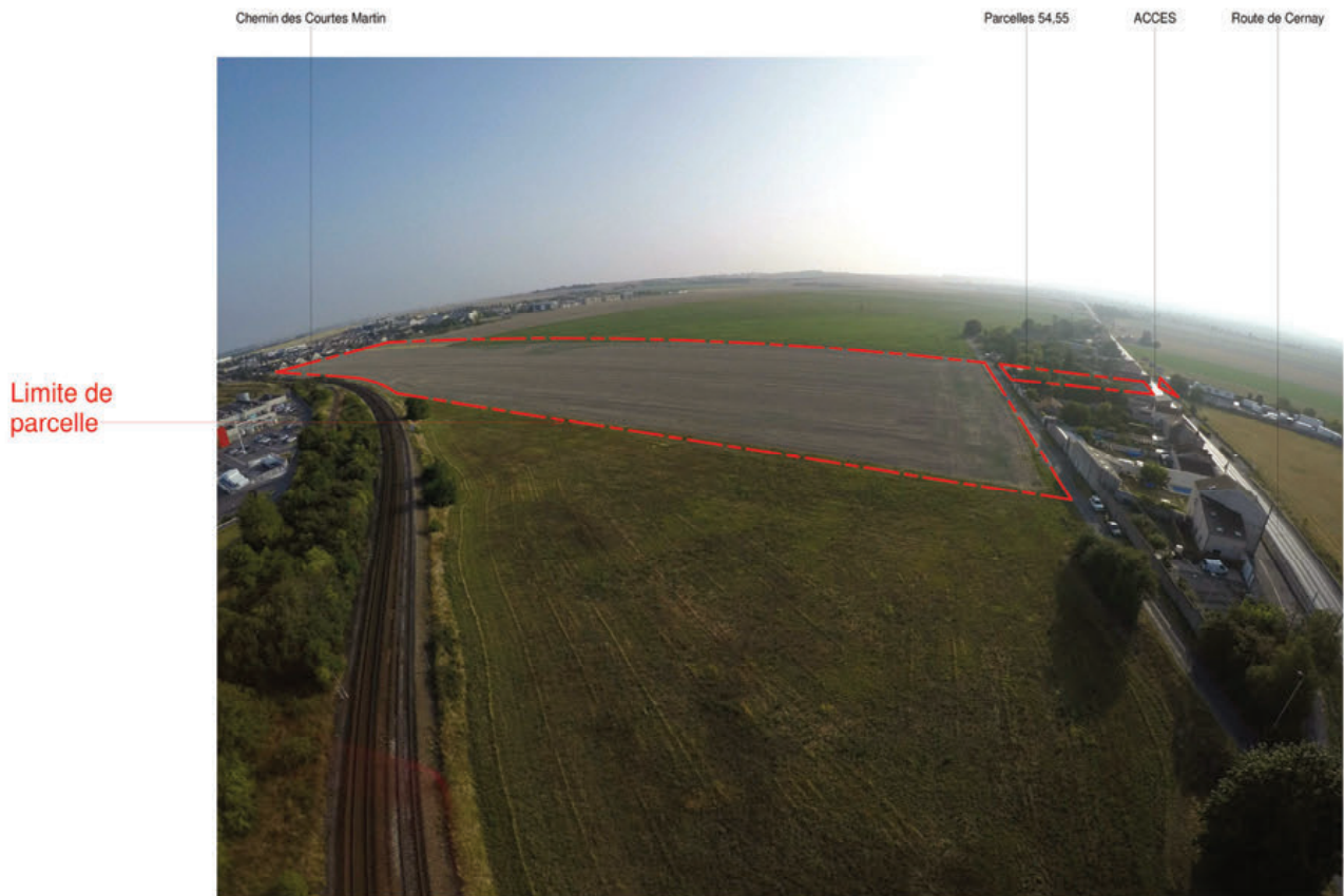
Figure 2 : Vue aérienne du projet (AWO)
