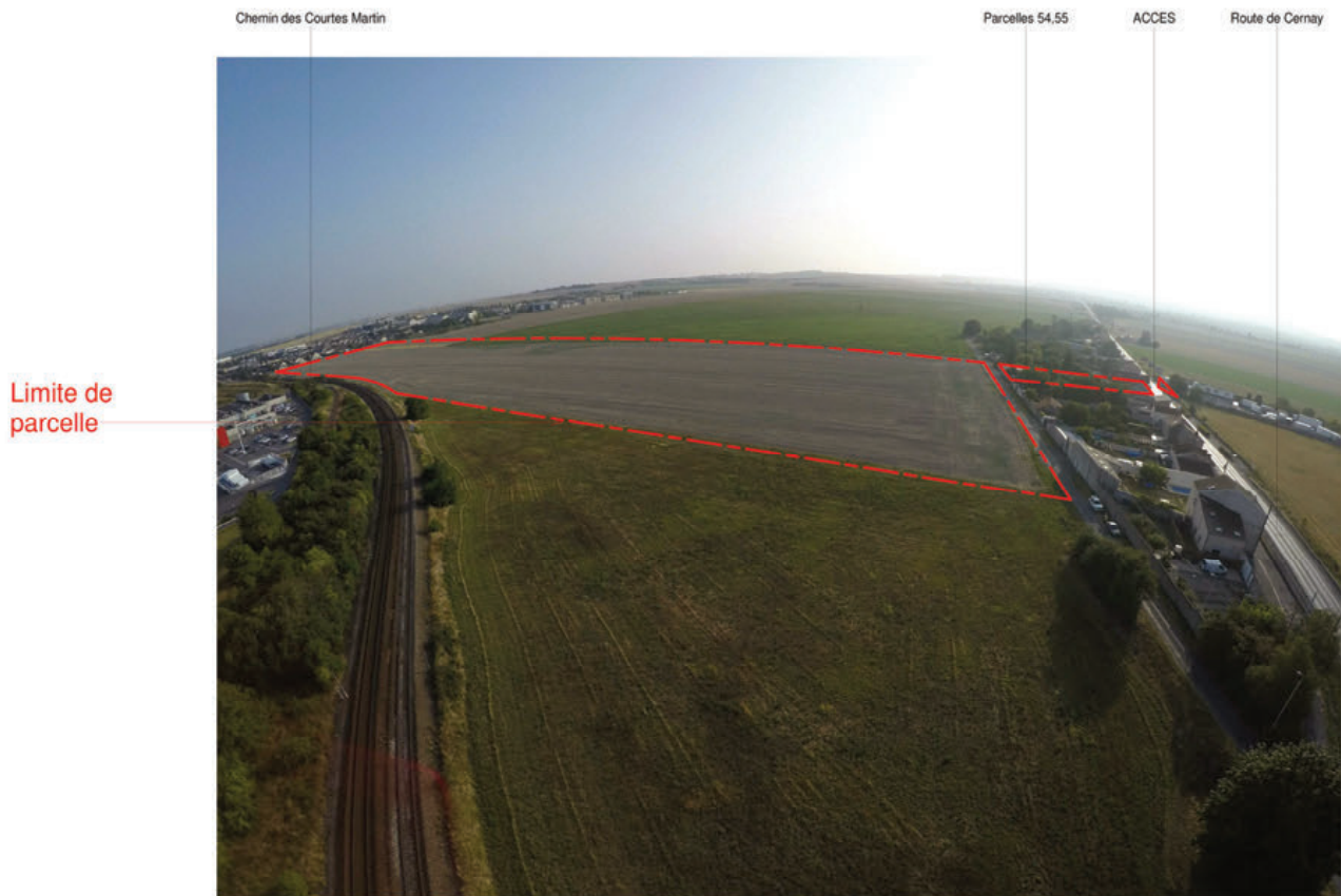
Figure 2 : Vue aérienne du projet (AWO)
