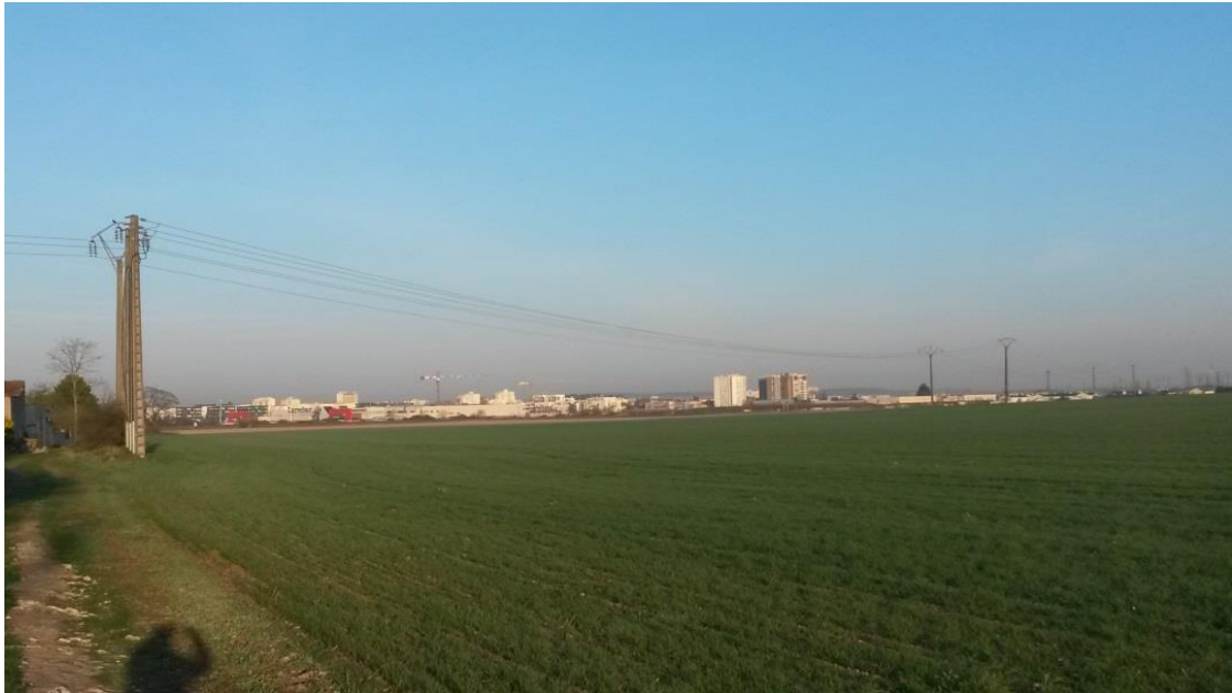
Vue des lignes haute tension depuis le Chemin rural n° 21 dit ancien Chemin de Reims à Cernay-lès-Reims
