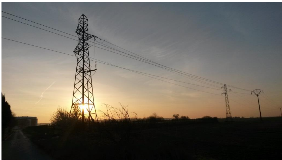
Vue des lignes haute tension depuis la rue des Courtes Martin
