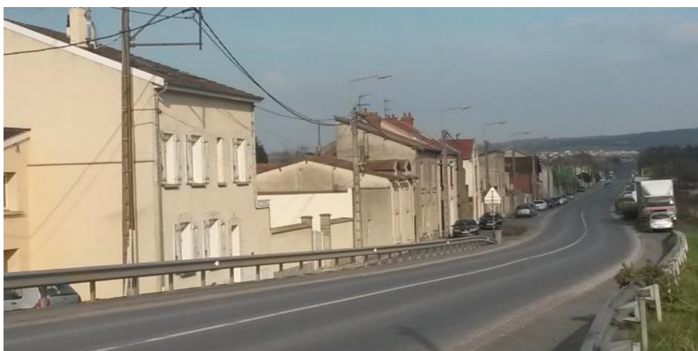
Vue depuis le Pont de la rue de Cernay
